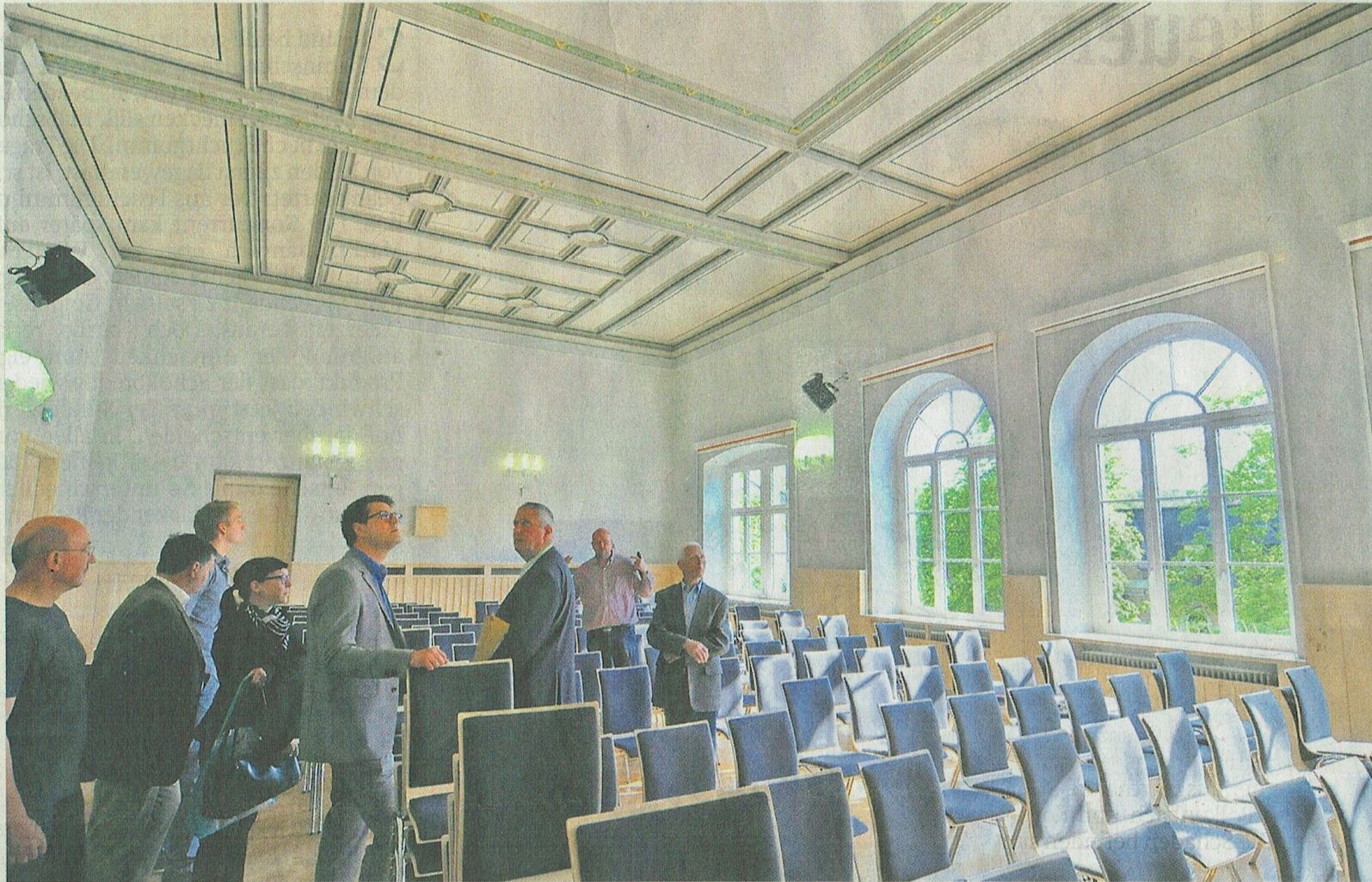
Die Aula ist als Festsaal des Gymnasiums mit neuer Holzvertäfelung und sanierter Stuckdecke etwas aufwendiger gestaltet worden. Der Denkmalschutz hatte dabei ein wichtiges Wort mitzureden. Die Stühle wurden neu angeschafft
